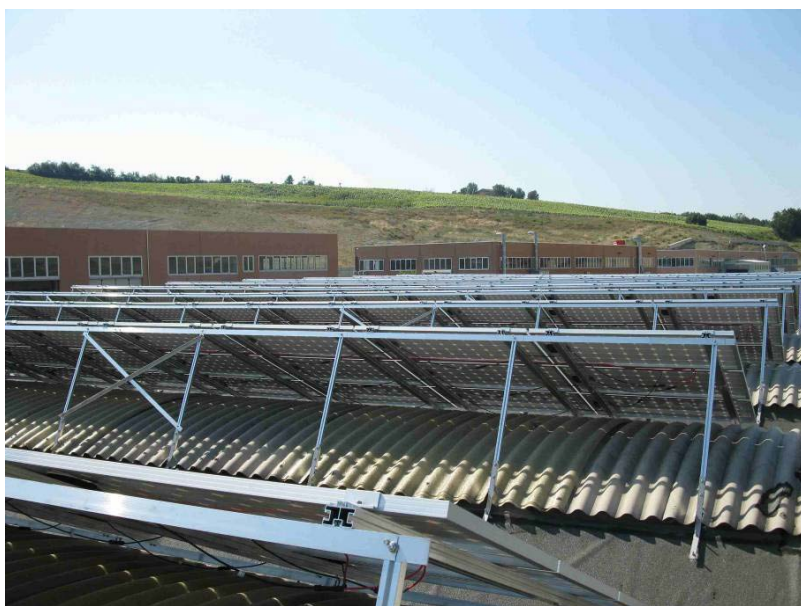
Figura 17 (a e b) - Esempio di installazione non idonea alla classificazione dell'impianto fotovoltaico nella categoria "su edifici" – Motivazione: alcune file di moduli fotovoltaici non sono appoggiate alla superficie di copertura.
