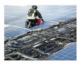
I moduli fotovoltaici continuano a produrre energia in presenza di luce solare anche in caso di avaria del sistema, per questo motivo è fondamentale verificare periodicamente i cablaggi elettrici e l'integrità dei singoli moduli con l'ausilio delle più moderne tecniche per la manutenzione predittiva come la termografia ad infrarosso.
